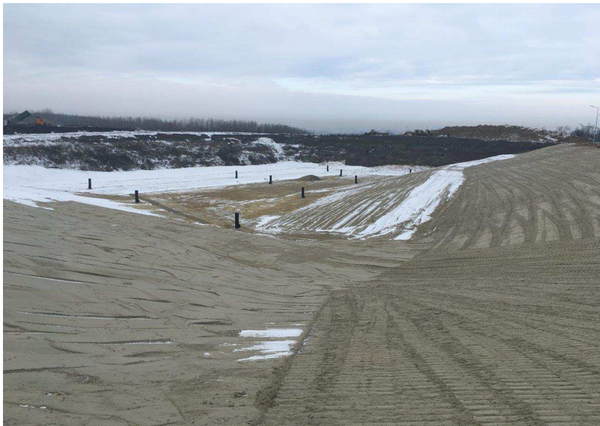
Zdjęcie 3. Rozbudowa składowiska odpadów
