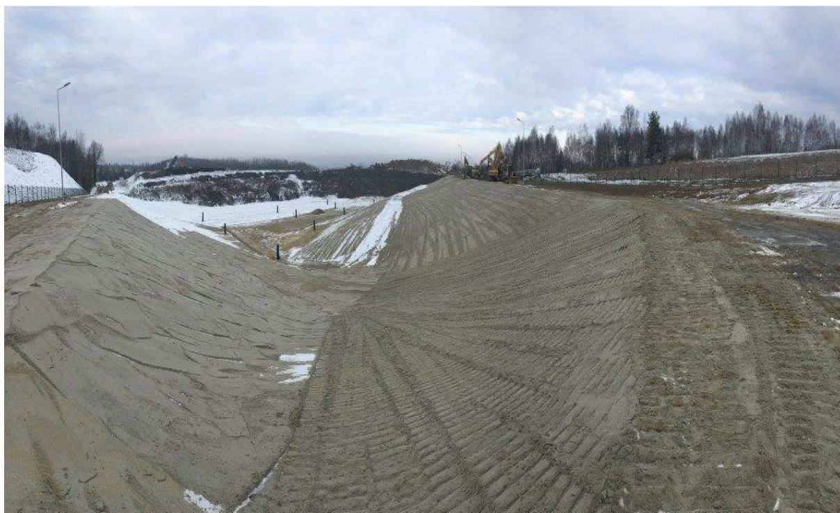
Zdjęcie 4. Rozbudowa składowiska odpadów
