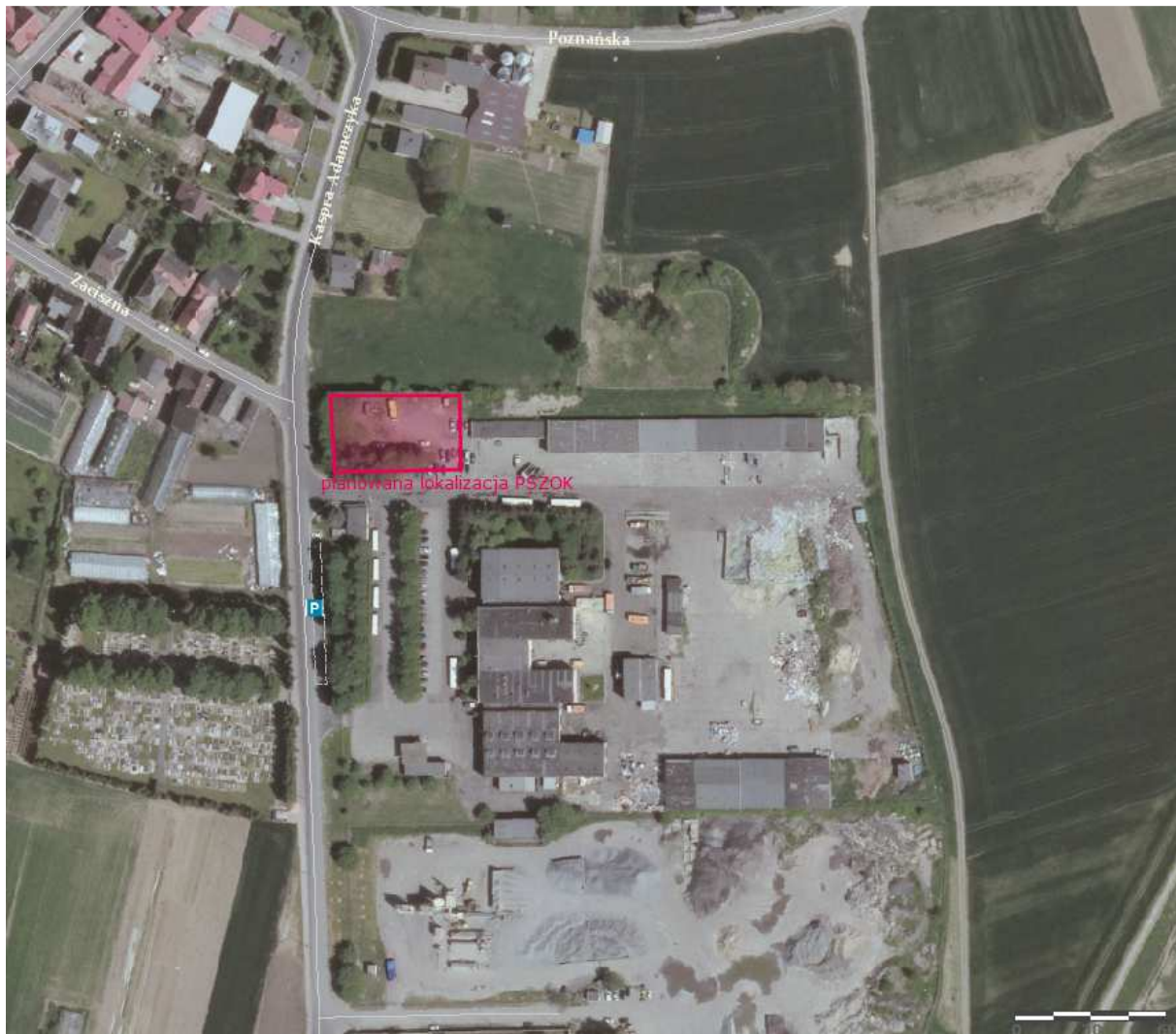
Zdjęcie 1. Planowana lokalizacja Punktu Selektywnej Zbiórki Odpadów Komunalnych
