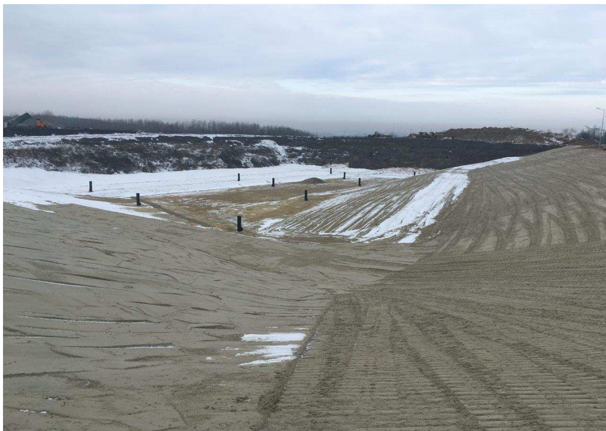
Zdjęcie 3. Rozbudowa składowiska odpadów
