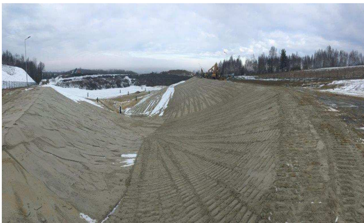
Zdjęcie 4. Rozbudowa składowiska odpadów
