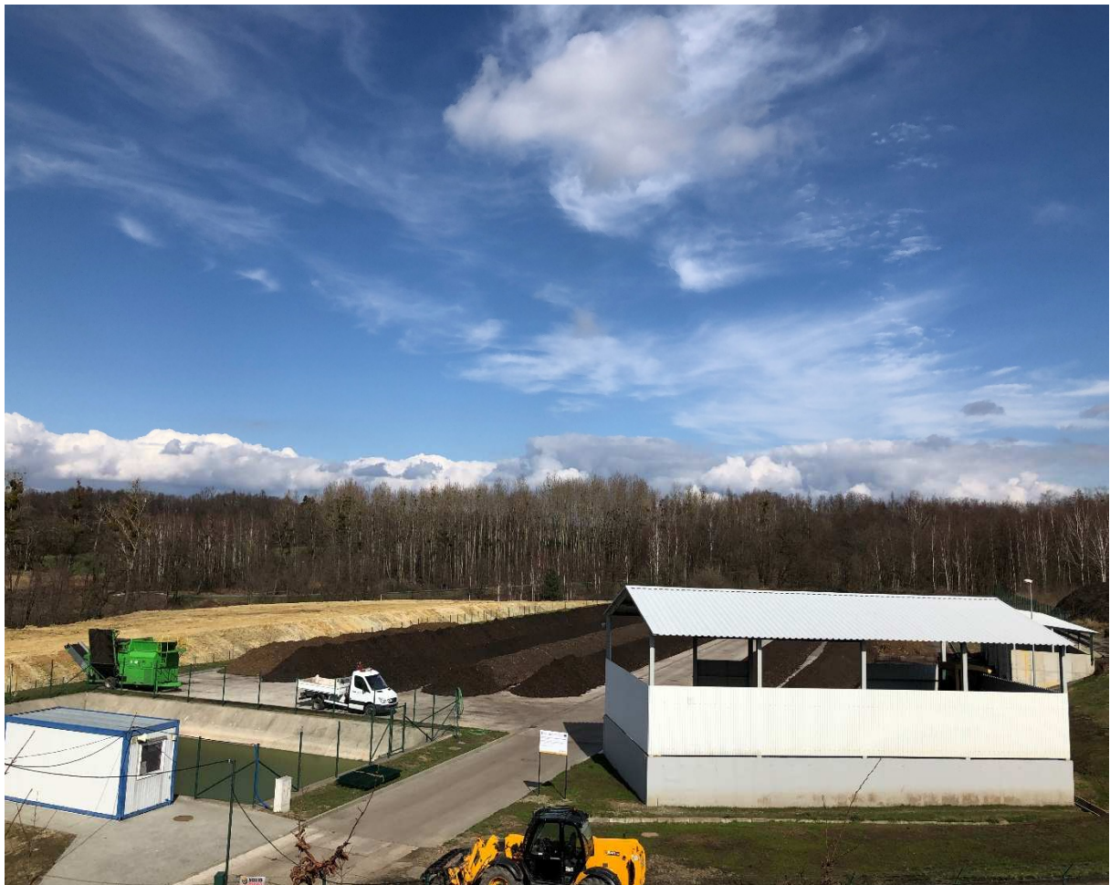
Zdjęcie 1. Rozbudowana kompostownia odpadów
