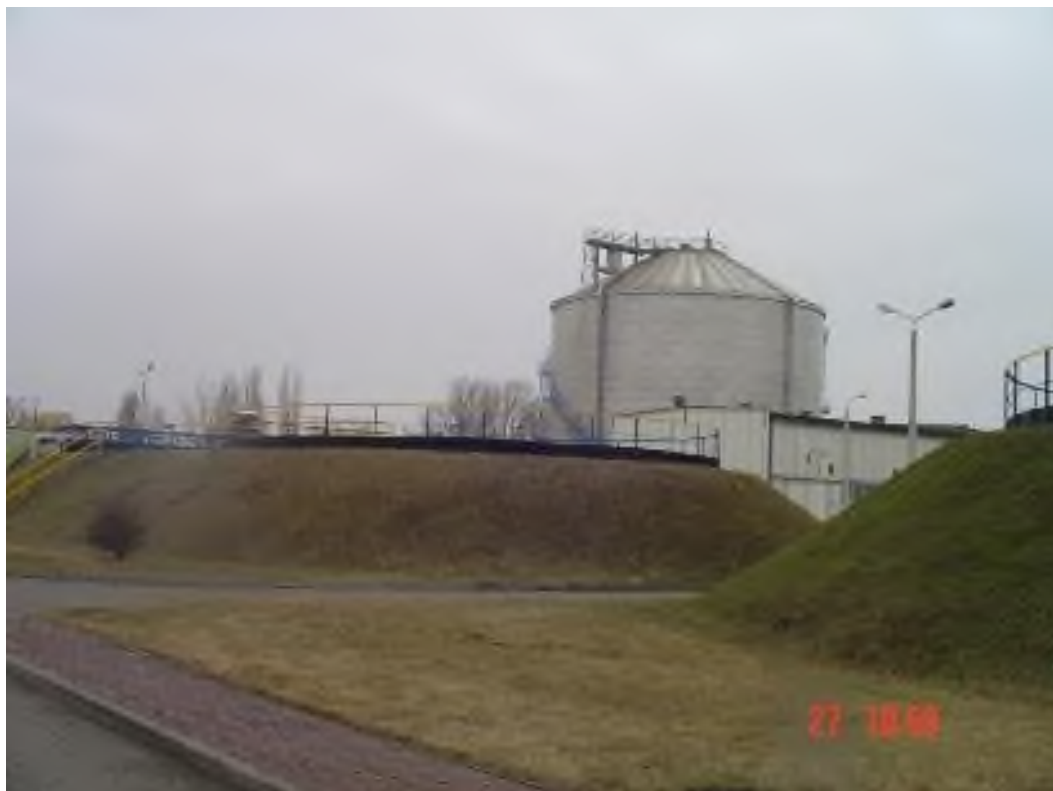
Zdjęcie nr 2 Oczyszczalnia ścieków
